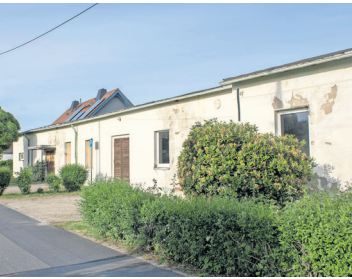
Die Tage für das alte Kulturhaus in Kleinopitz sind gezählt. In Kürze soll das als nicht wirtschaftlich sanierungsfähig eingestufte Gebäude dem Erdboden gleichgemacht werden.
